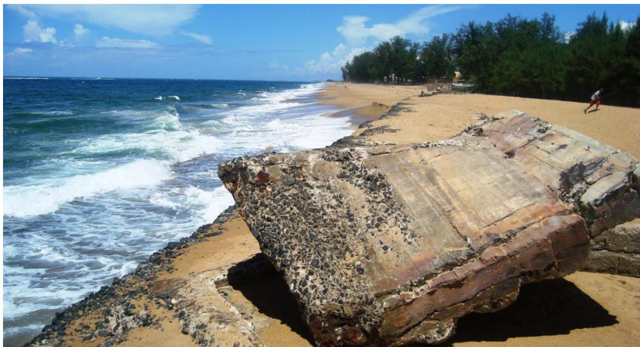
Destruction de la digue de protection à cause de l'érosion marine.
